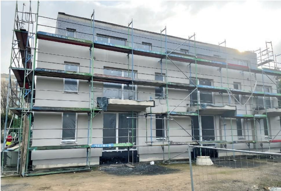
Das wird richtig schön: Die Fenster wurden bereits eingesetzt, Flächen gedämmt und das Dach abgedichtet. Nun arbeiten sich die Technikgewerke vom Keller hoch in die Obergeschosse.
