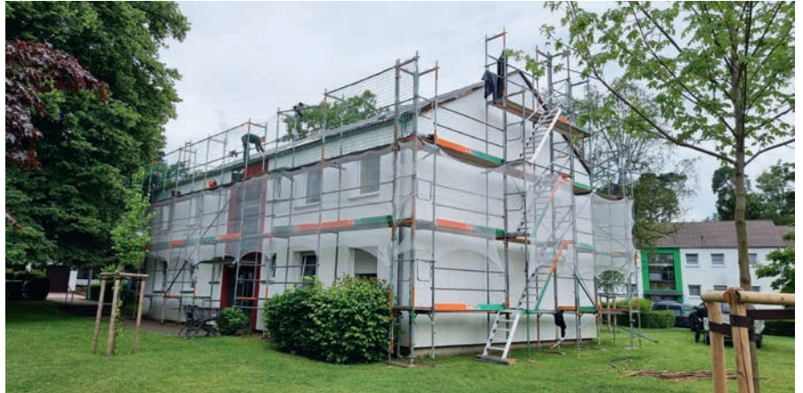
Eins aufs Dach gegeben: Die neue Eindeckung in der Bourgoinstraße steigert die Energieeffizienz und sorgt dank neuartiger Dachziegel für eine bessere Luftqualität.
