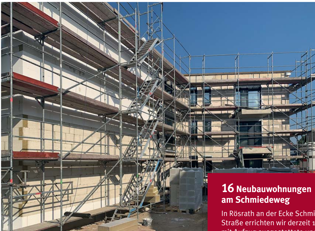
Der Rohbau steht, die Fenster sind drin: Jetzt kann der Innenausbau an der Ecke Schmiedeweg/Brander Straße beginnen.
