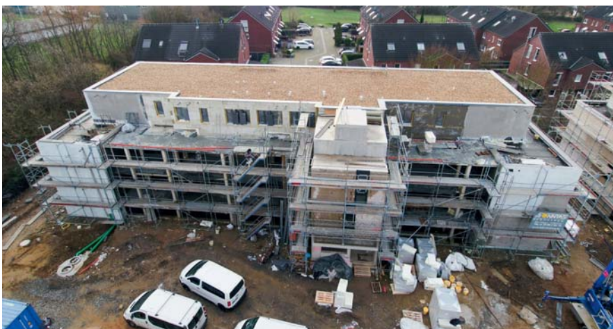
Dach ist drauf, Fenster sind drin: Nach Abschluss der Rohbauarbeiten geht es für unsere Handwerker an den Innenausbau.
