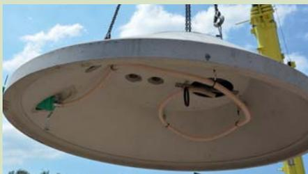
*Auf jeden Topf passt ein Deckel: Der Betondeckel wird per Kran auf den Behälter aufgesetzt.*
