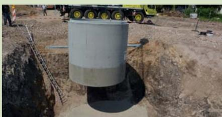
*Punktlandung: Die Betonbehälter werden später mit Holz-Pellets befüllt, mit denen die Gebäude effizient und nachhaltig beheizt werden.*
